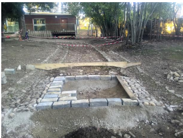
Technique avec gabarit pour chemin pavé avec évacuation des eaux pluviales à La Saussinette
